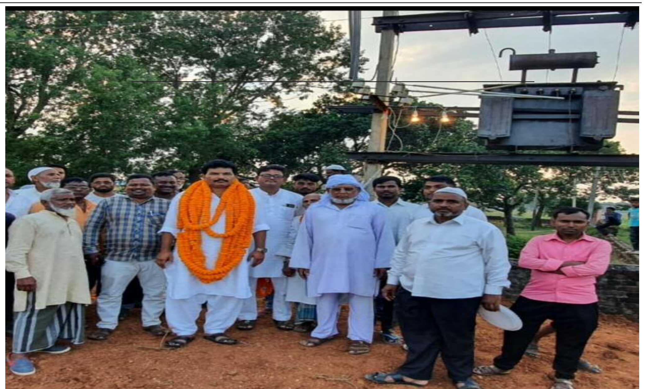
ट्रांसफार्मर का उद्घाटन में मौजूद ग्रामीण
