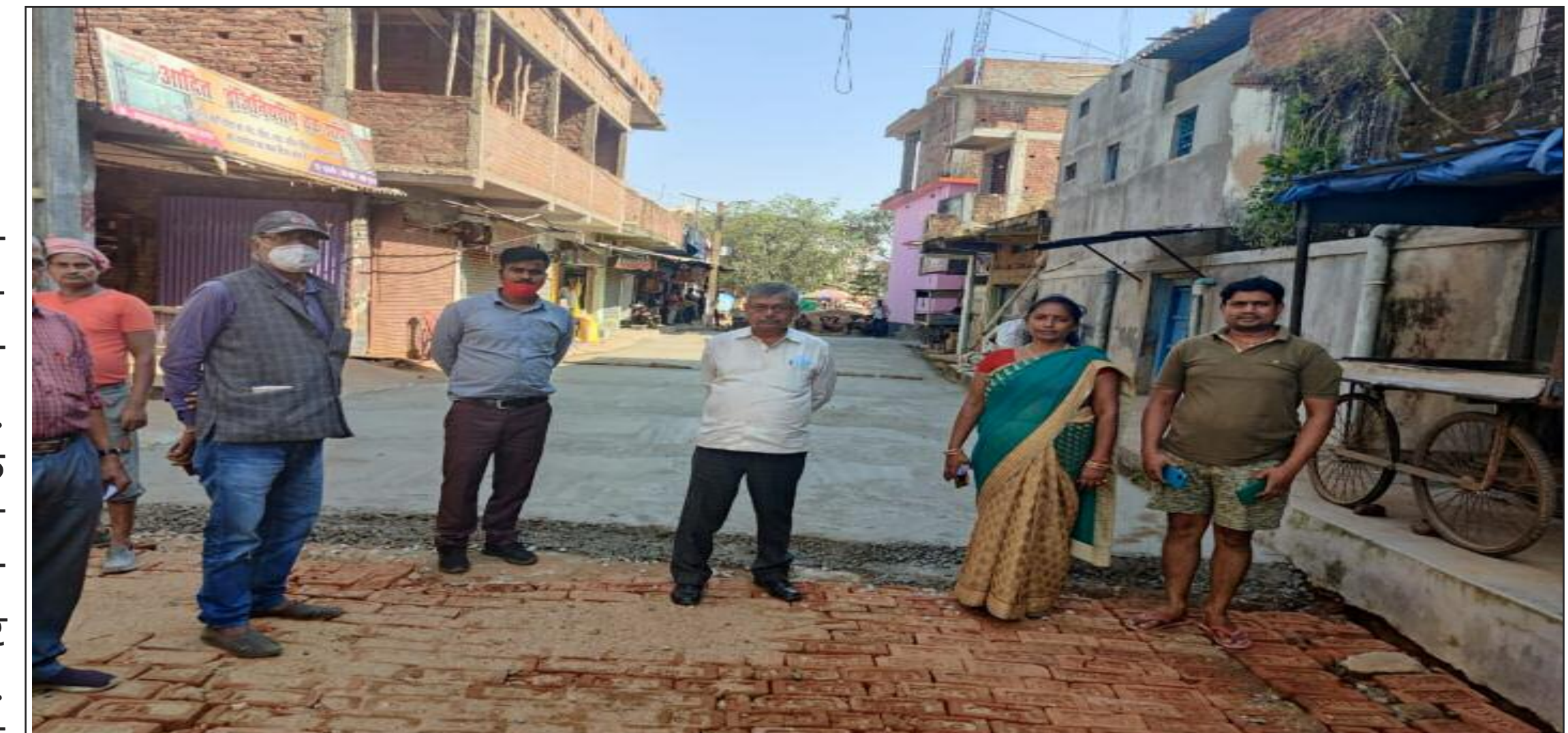
पीसीसी सड़क निर्माण कार्य का निरीक्षण करती मुखिया अनीता देवी एवं अन्य
