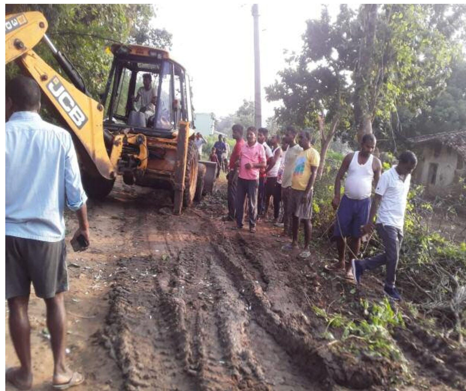
सड़क मरम्मत कार्य में जुड़े ग्रामीण व अन्य
