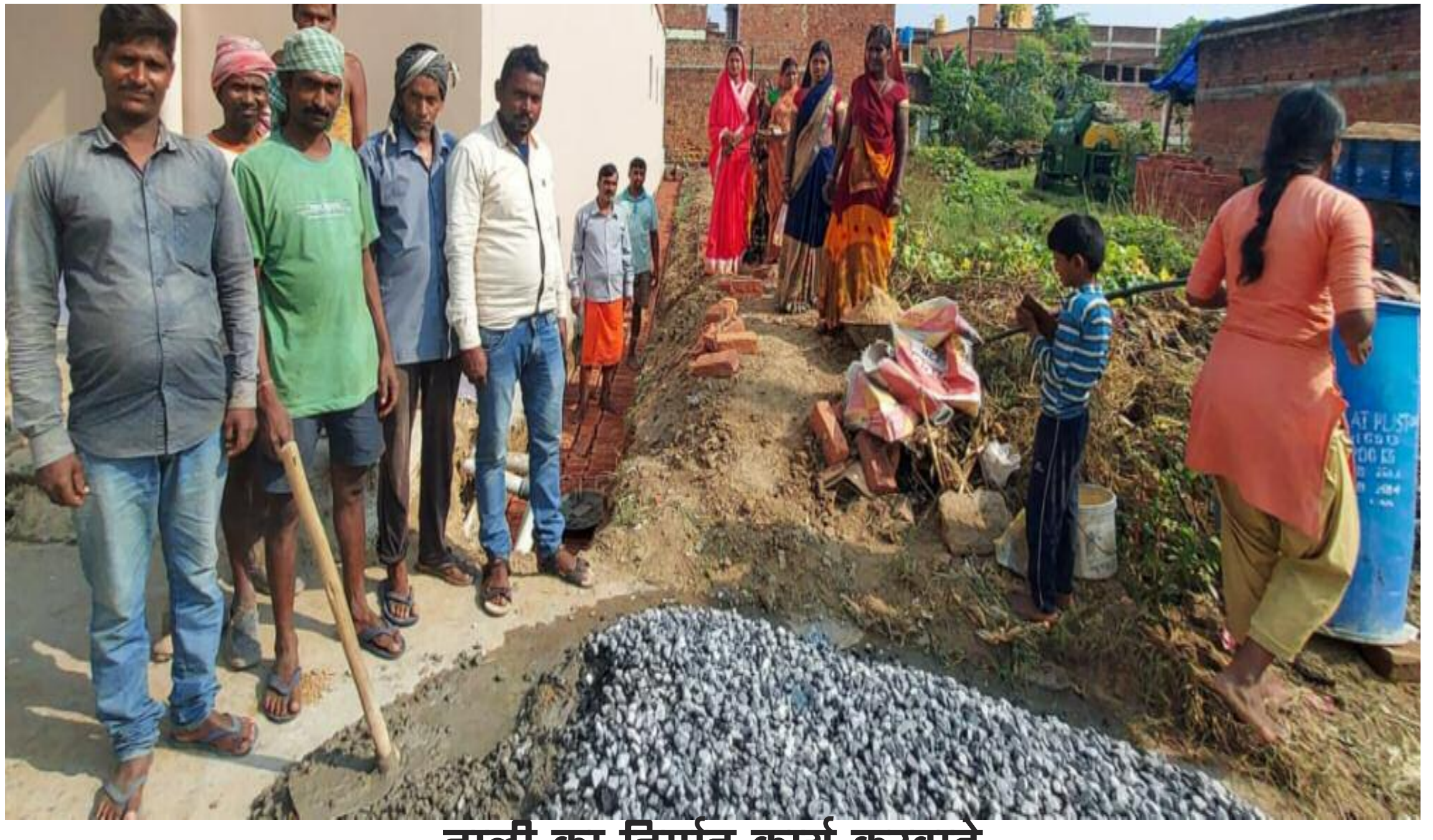
नाली का निर्माण कार्य करवाते
