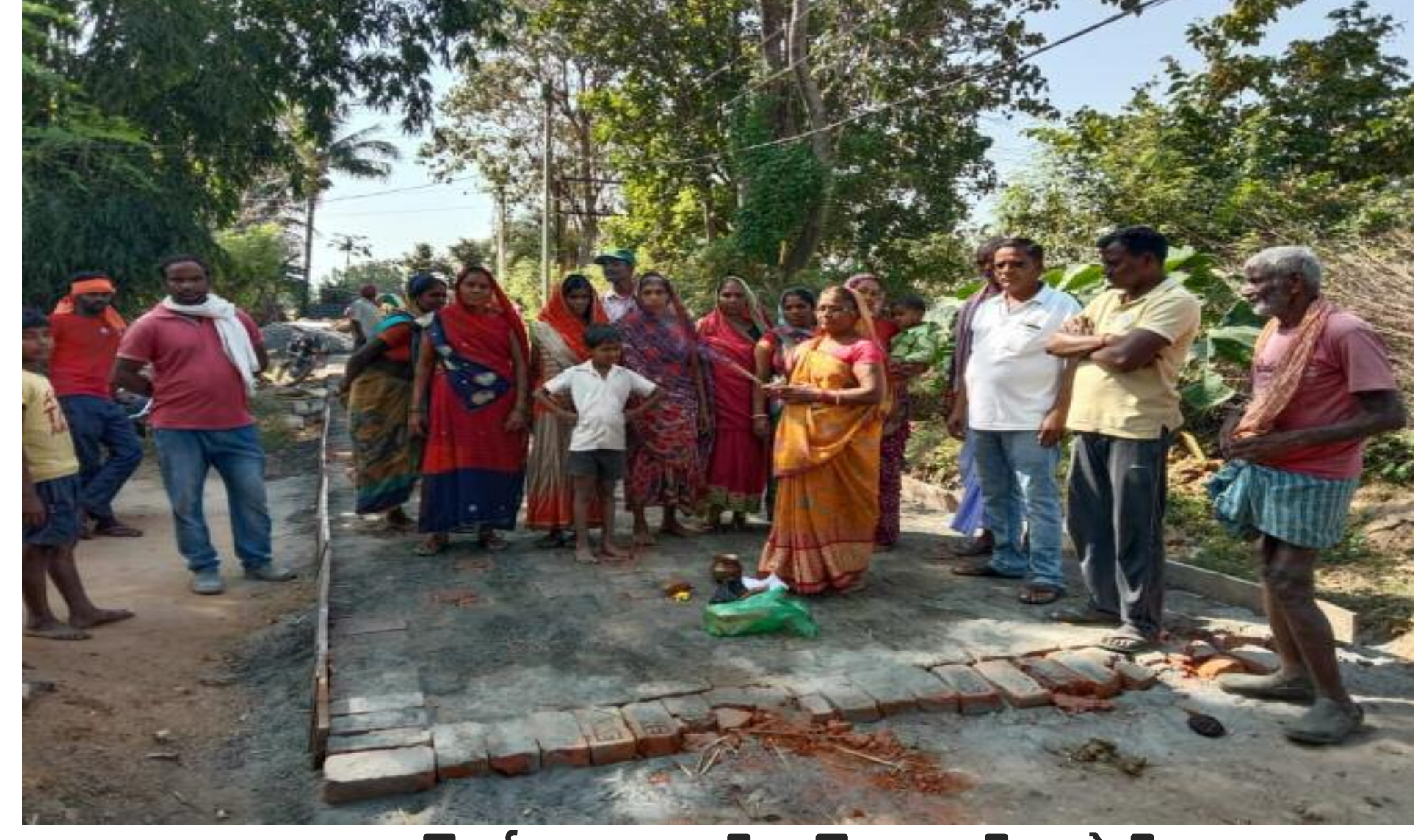
सड़क निर्माण करवाती मुखिया सीता देवी
