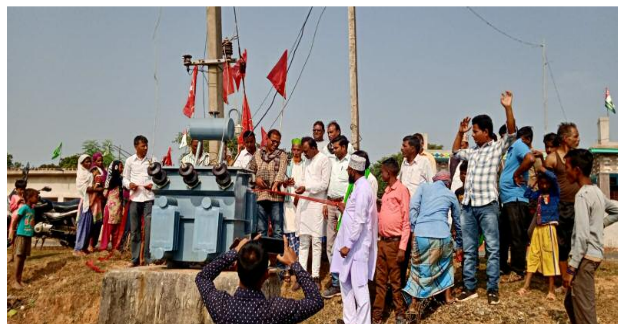
ट्रांसफार्मर लगाते ग्रामीण
