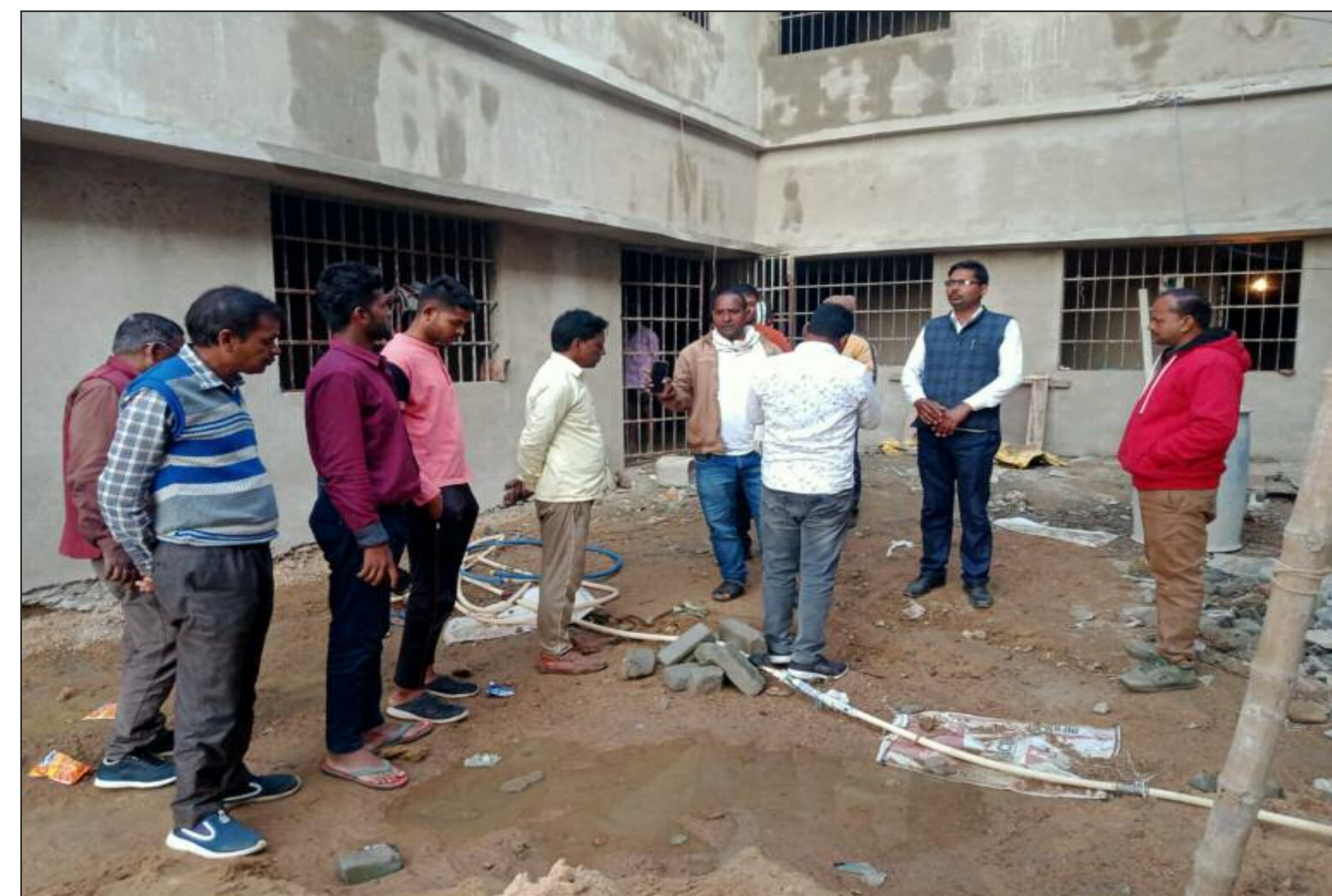
निर्माणाधीन भवन का निरीक्षण करते मुखिया एवं अन्य
