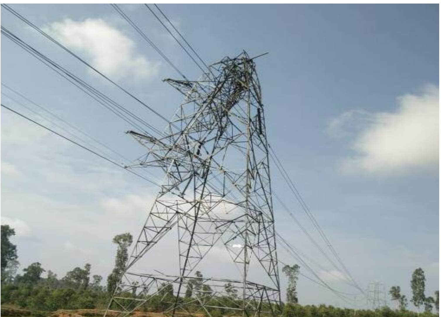
विष्णुगढ़ में हाइटेशन टावर के एंगल चोरी के दौरान क्षतिग्रस्त हुआ टावर
